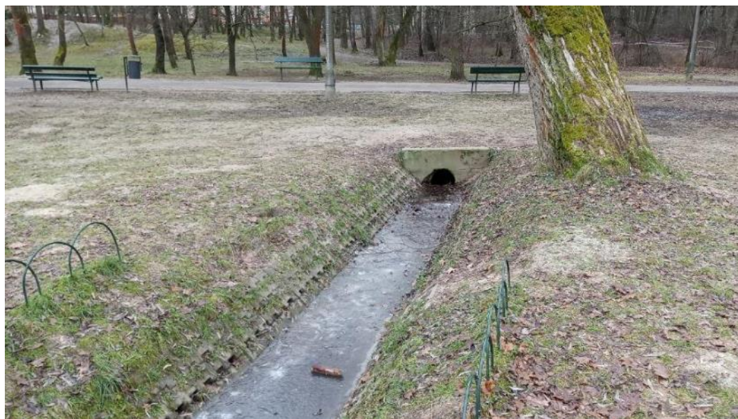
Fotografia 9. Przepust P8 (źródło: własne)
