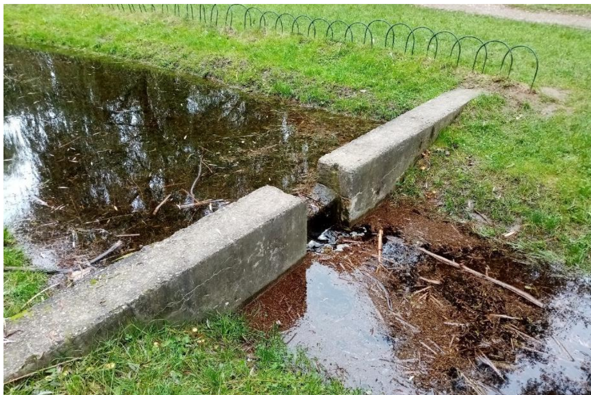
Fotografia 25. Zastawka ograniczająca odpływ wody ze stawu S2 do stawu S1 (źródło: własne)
