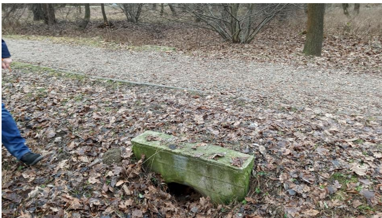
Fotografia 19. Przepust P6 (źródło: własne)
