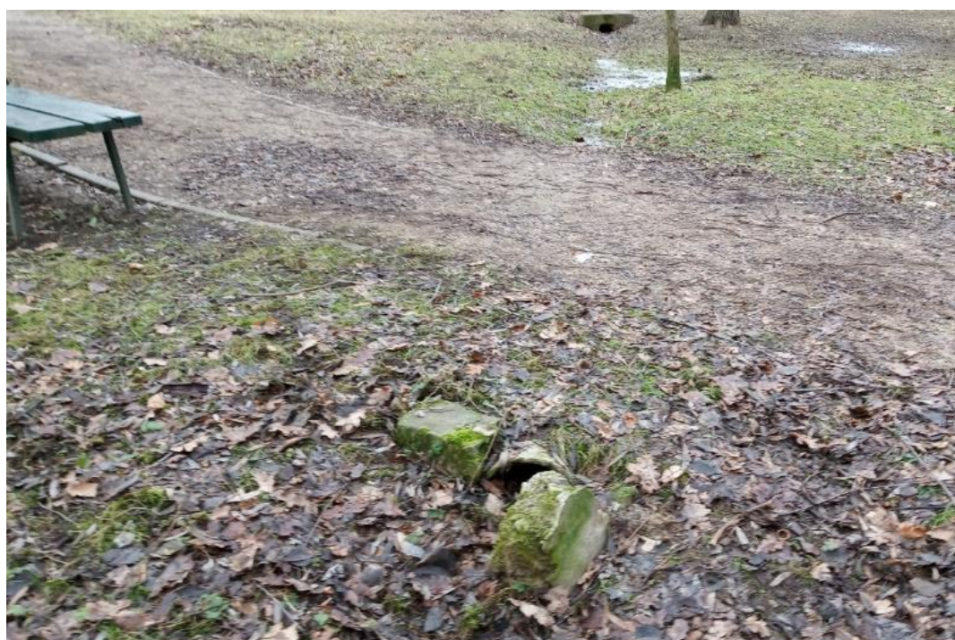
Fotografia 10. Przepust P10 (źródło: własne)
