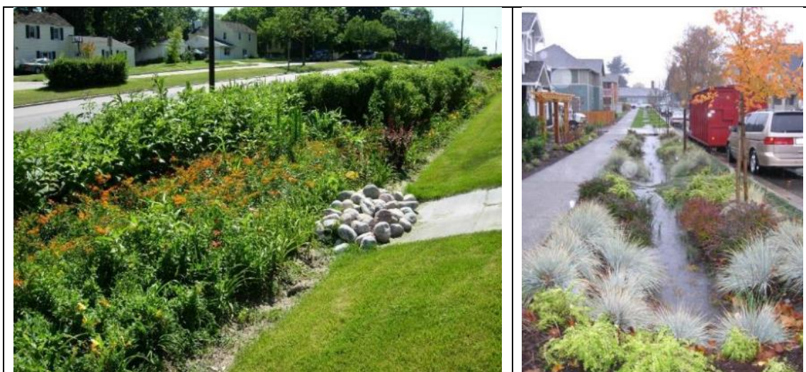
Fotografia 40. Przykładowe realizacje muld chłonnych (cc:1.0)
