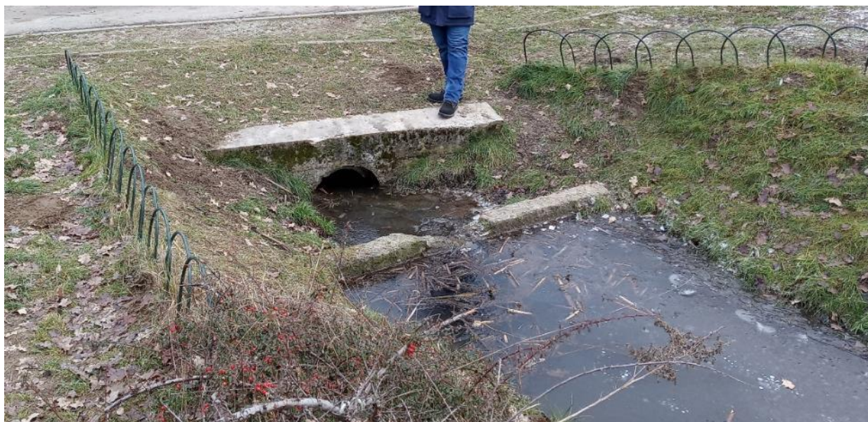
Fotografia 29. Widok na staw S3, przepust P2 i zastawkę ograniczającą przepływ z stawu S3 do S2 (źródło: własne)
