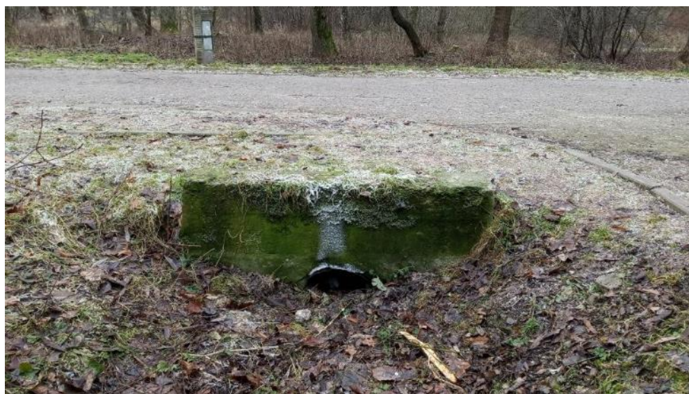
Fotografia 21. Przepust P5 (źródło: własne)
