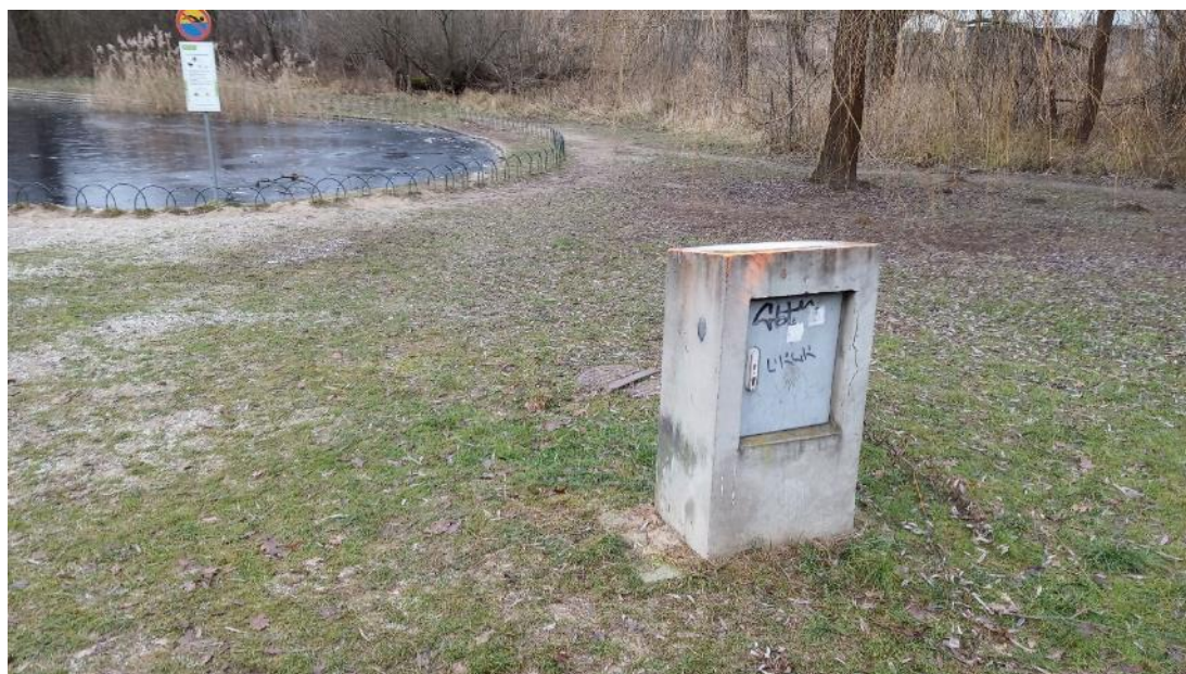
Fotografia 27. Widoczne zasilanie i lokalizacja pompy opróżniającej staw S1 (źródło: własne)
