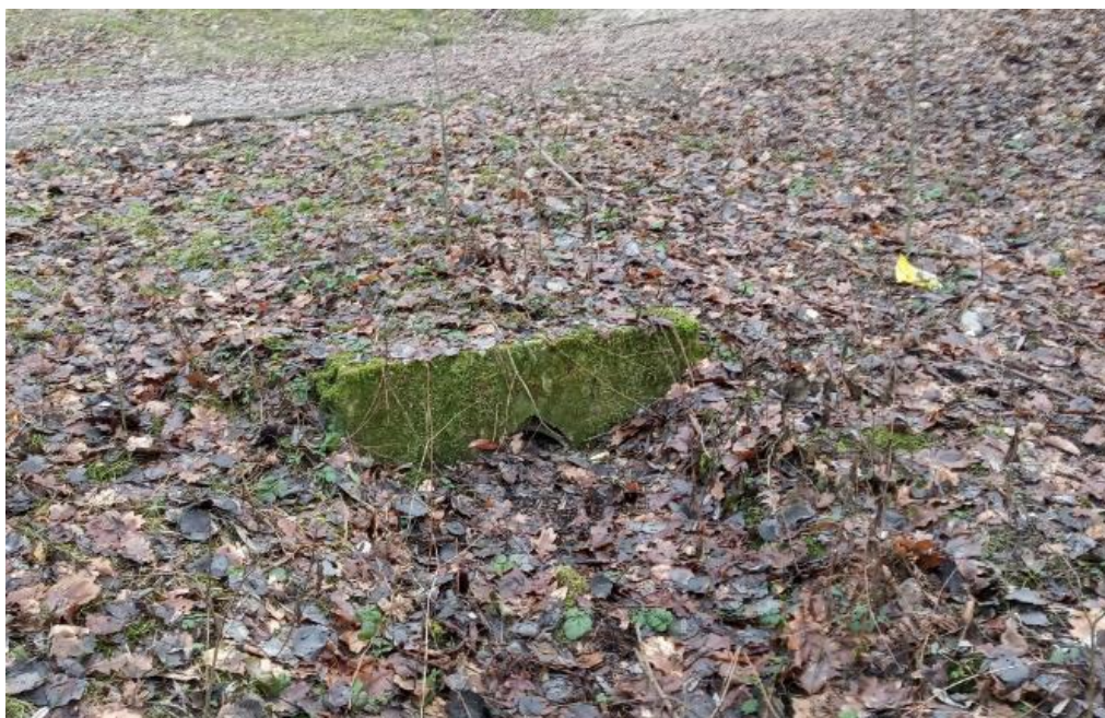
Fotografia 11. Przepust P11 (źródło: własne)
