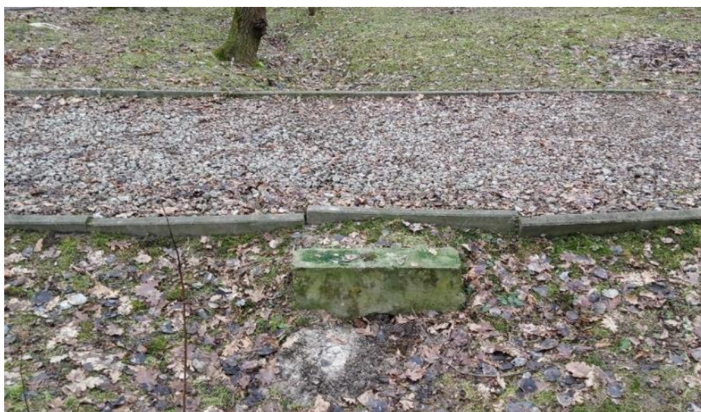
Fotografia 12. Przepust P12 (źródło: własne)
