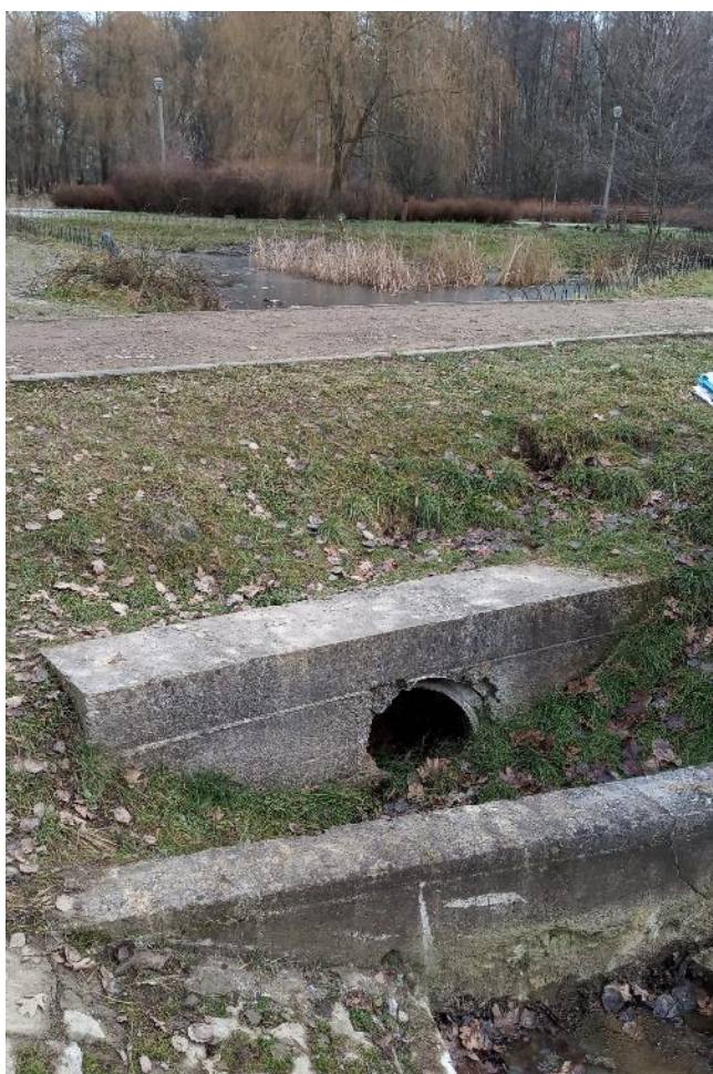
Fotografia 32. Widok na przepust P3, zasilający S3, od strony S4 (źródło: własne)
