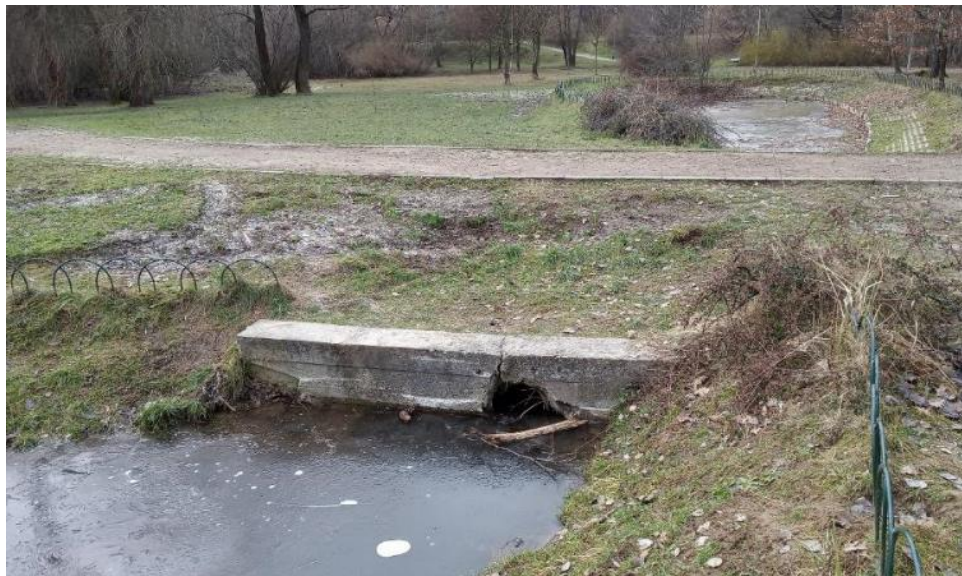
Fotografia 31. Widok na przepust P3 (źródło: własne)
