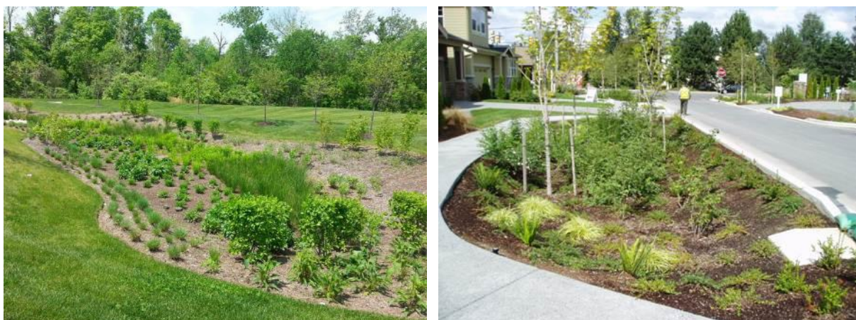
Fotografia 39. Przykłady realizacji obniżeń z bioretencją
