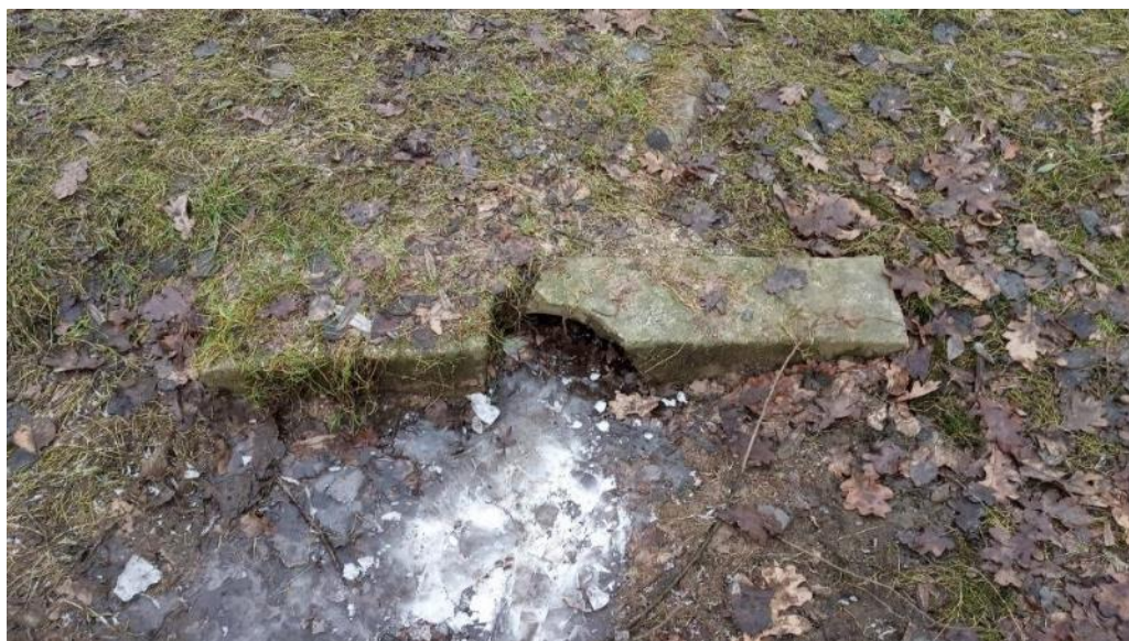
Fotografia 14. Przepust P9 (źródło: własne)
