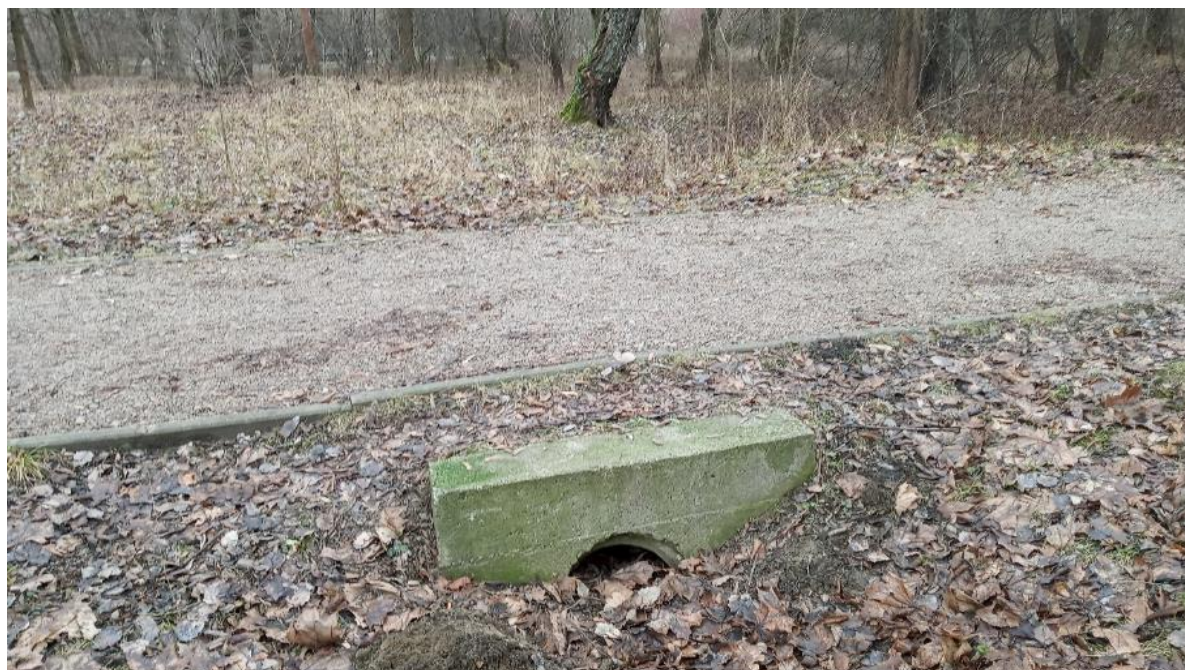
Fotografia 16. Przepust P7 (źródło: własne)
