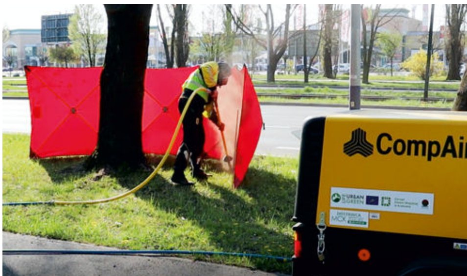
Ryc. 4.4. Zabieg napowietrzania gleby prowadzony przy al. Pokoju
